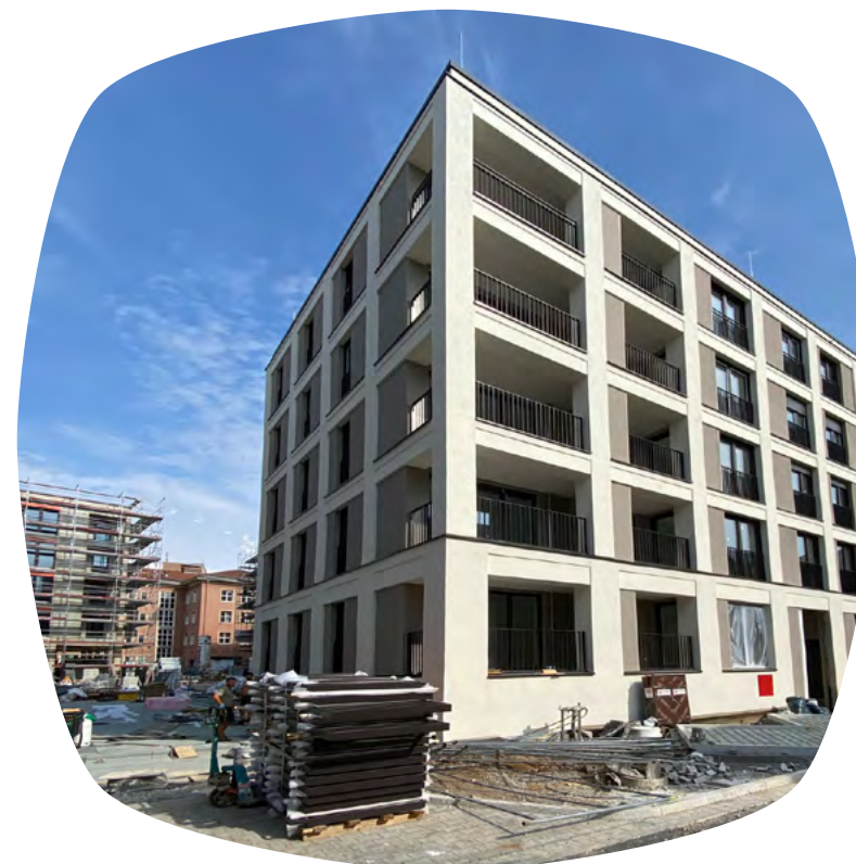
← Neubau an der Sieboldstraße (Abbildung 36)
